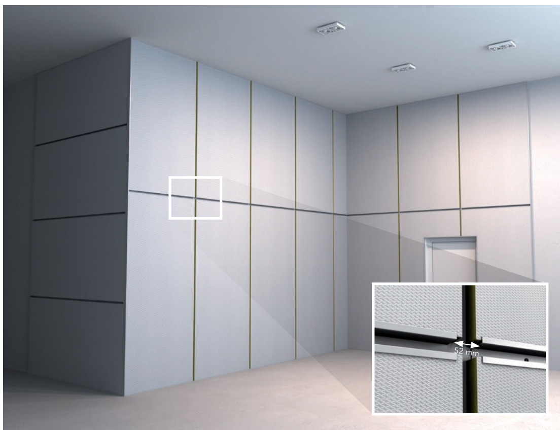
2.4 Zamontować pozostałe panele ściennie i poziome profile HAT, kierując się ku środkowi.
