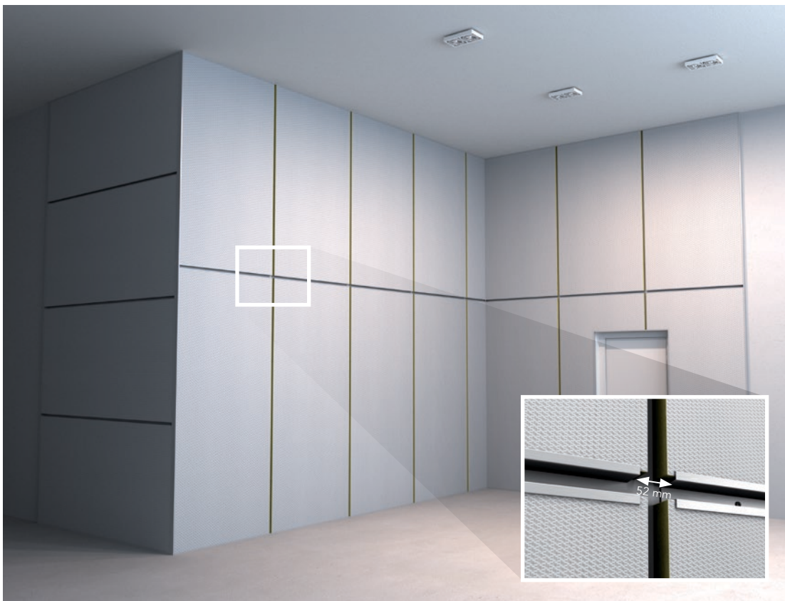
2.4 Installeer de rest van de wandpanelen en horizontale HAT-profielen en werk verder naar het midden toe.
