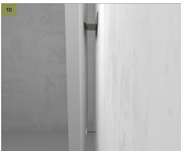
Placez votre panneau mural Rockfon Eclipse sur le profilé de fixation murale et ajustez l'écarteur jusqu'à ce que le panneau mural Rockfon Eclipse soit à niveau.
