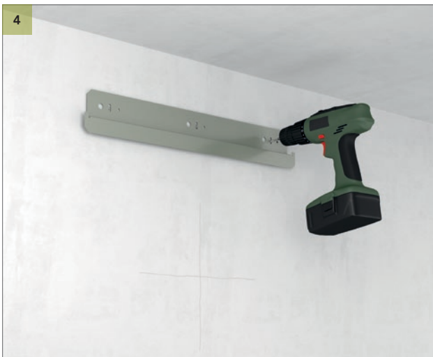
4 Percez les trous et installez le profilé de fixation murale.
