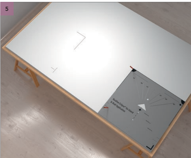
Placez l'outil de marquage au dos du panneau mural Rockfon Eclipse, dans le coin inférieur droit. Marquez au crayon les lignes formant le centre en utilisant le coin supérieur droit de l'outil de marquage et la position de l'écarteur.
